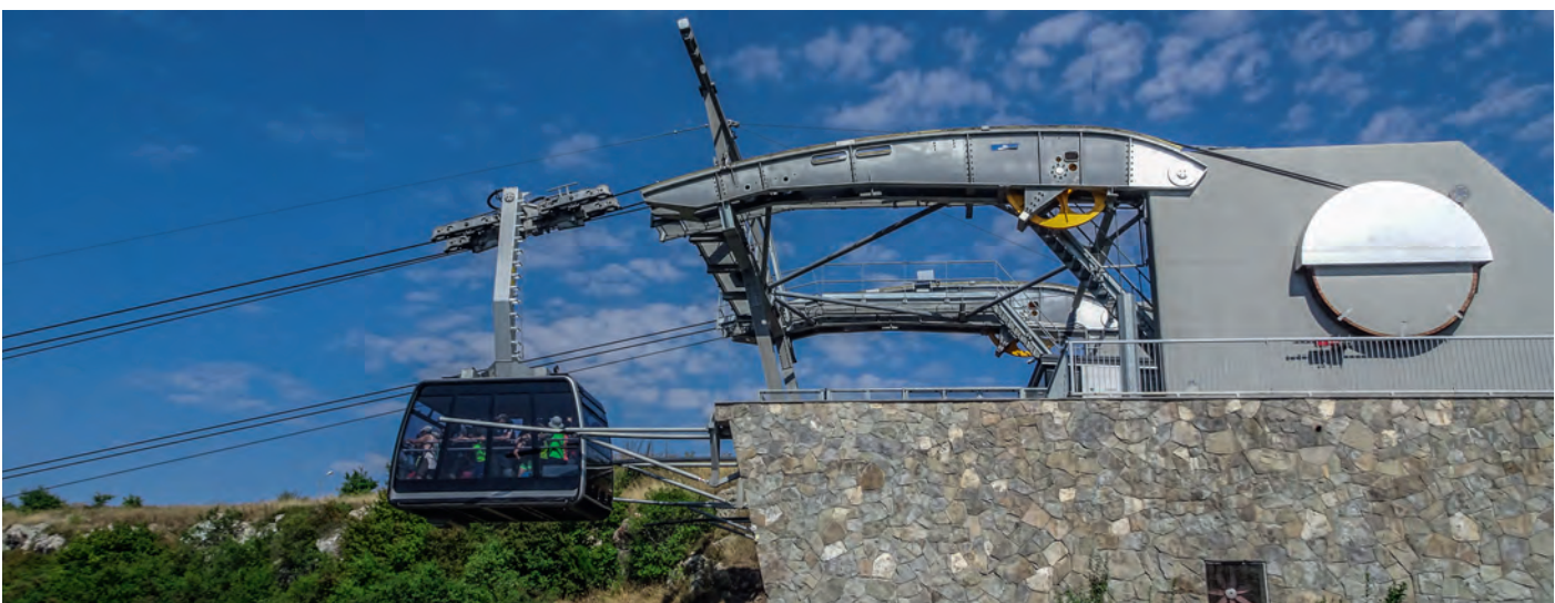
Die Seilbahn „Wings of Tatev“
